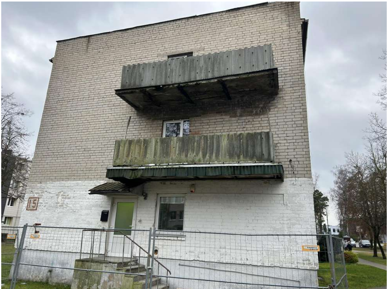
Pav. 2. Šiaurinis fasadas.
